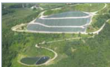
1. Мусорная свалка в исходной стадии
