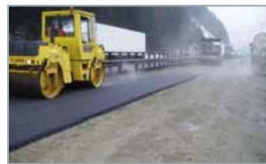
6. При необходимости укладка асфальтового слоя
