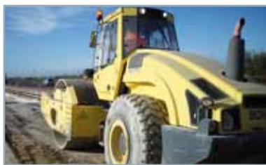
5. Уплотнение обработанного и улучшенного слоя
