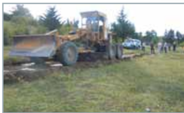
2. Снятие грунта и сооружение земляной основы
