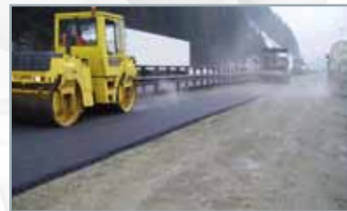
6. При необходимости укладка асфальтового слоя
