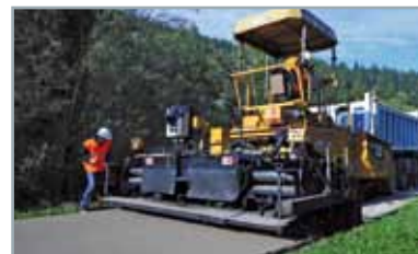
3. Укладка смеси с помощью дорожной отделочной машины
