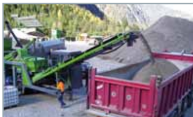
2. Изготовление готовой смеси Nanoalps® System DRAIN с помощью смешивающей установки
