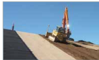
3. Укладка смеси с помощью специальной техники
