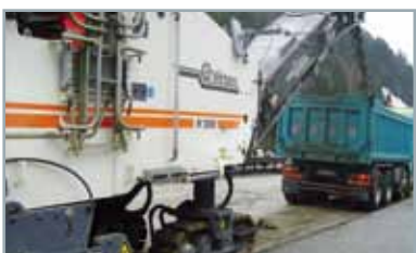
1. Снятие асфальтового слоя с помощью фрезы
