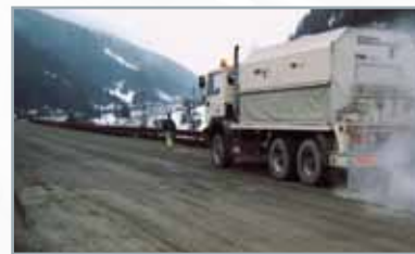
3. Нанесение вяжущего вещества с помощью распыляющей машины
