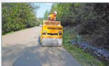
4. Уплотнение и вальцевание уложенного слоя
