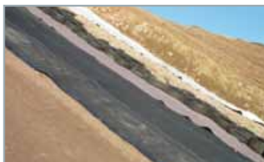
5. Конечная стадия – укрытие свалки
