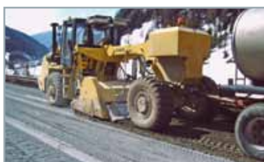
4. Стабилизация наявного на месте грунта с добавлением Nanoalps® System SOIL
