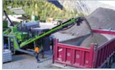
2. Preparazione della miscela Nanoalps® System DRAIN mediante impianto di miscelazione
