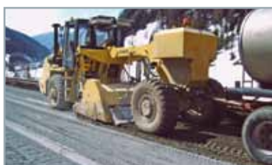
4. Stabilizzazione del terreno in situ con Nanoalps® System SOIL
