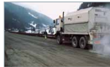
3. Stesura del cemento tramite spandi cemento
