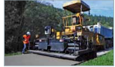
3. Stesa della miscela mediante finitrice
