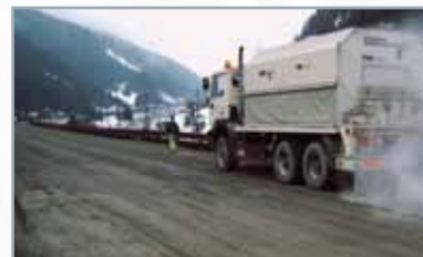
3. Stesura del cemento tramite spandi cemento
